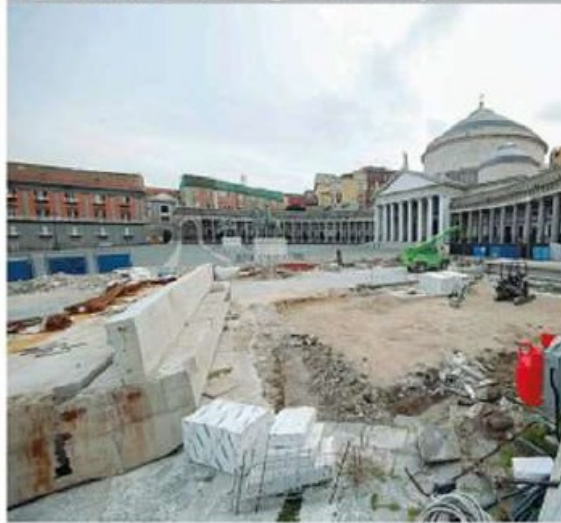
Il grande «buco» della ventola di areazione per la metro in piazza del Plebiscito è stato chiuso; «presto il cantiere si ridurrà nella zona dei porticati rimanendo soprattutto nella zona antistante la Prefettura», spiega il responsabile dell'urbanistica, Carmine Piscopo.
