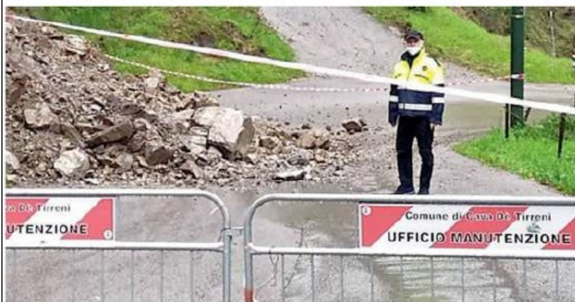
La frana sulla strada transennata dall'ufficio manutenzione
