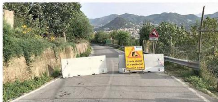
La strada provinciale 75 che collega Cava de' Tirreni e Vietri sul Mare
