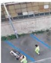
Gli operai al lavoro ad Angri
